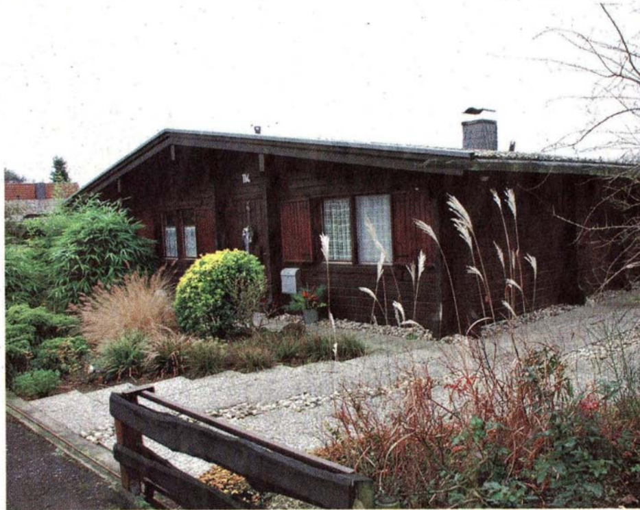
Rund 85 Prozent der Bewohner in der Bergflagge, Immen- und Geißheide wohnen fest in dem Bereich, der ursprünglich als Ferienhaussiedlung gedacht war. DZ-Fotos: Jürgen Primus
